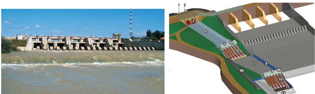
Fig. 10. Overview and principle scheme of the Zăvoiul Orbului SHPP [12]
