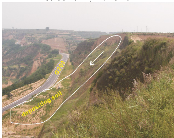
Fig. 1. The Jijiayuan landslide
