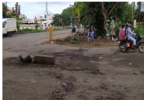
Fig. 7 Pot holes at MIT chowk
