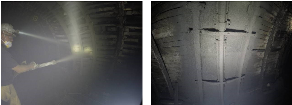
Fig. 2. Applying a shotcrete layer (photo P.Ficek).
